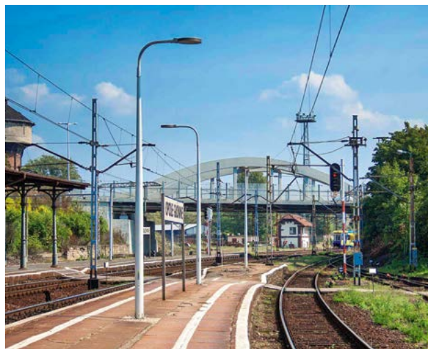
Słupy kompozytowe Alumast na dworcu w Opolu
